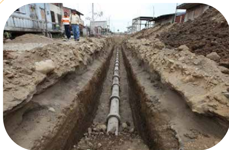
Con fines de cimentación para proyectos de agua y alcantarillado
